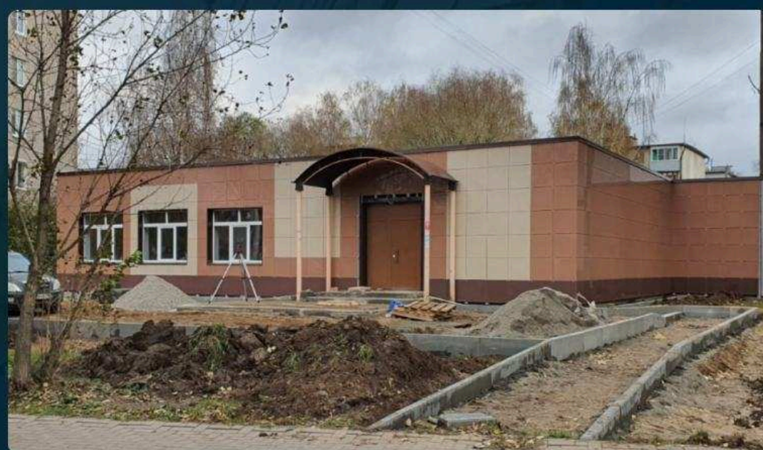
Заказчик: МУК ЦСДБ Г. Ярославля Адрес объекта: г. Ярославль, проспект Дзержинского, д.59 Виды работ: Капитальный ремонт фасада
