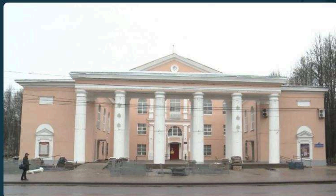
Заказчик: МАУ ДК «Гамма» Адрес объекта: г. Ярославль, Спартаковская ул., 7 Виды работ: Капитальный ремонт фасада
