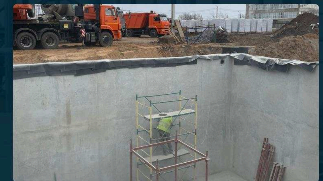
Заказчик: АО «Промтехмонтаж-диагностика» (АО «ПТМ-Д») Адрес объекта: Ярославская область, г. Рыбинск, Ярославский тракт, 62 Виды работ: Устройство резервуара пожаротушения и насосной станции
