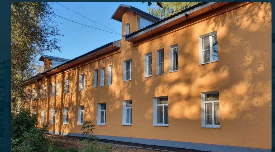
Жилой дом в пос Прибрежный Адрес объекта: Муниципальное казенное учреждение «Агентство по муниципальному заказу ЖКХ» города Ярославля Виды работ: Капитальный ремонт здания
